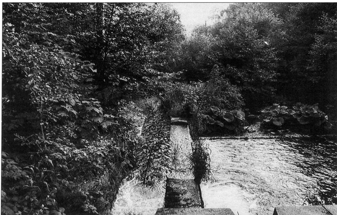
Abb. 3 Das Hänner Wuhr bei der Ableitung in Hottingen. Links die sogenannte Schaale , durch eine Streichrinne von der Murg getrennt. (Bild: Markus Lüthy, Murg)
