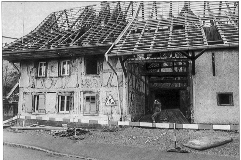
Abb. 11 Möhl, Bahnhofstrasse 54. Abbruchsituation nach Entfernung der Dachhaut: Das zur Dokumentation freigelegte Fachwerk lässt das ursprüngliche Erscheinungsbild für kurze Zeit erahnen.
