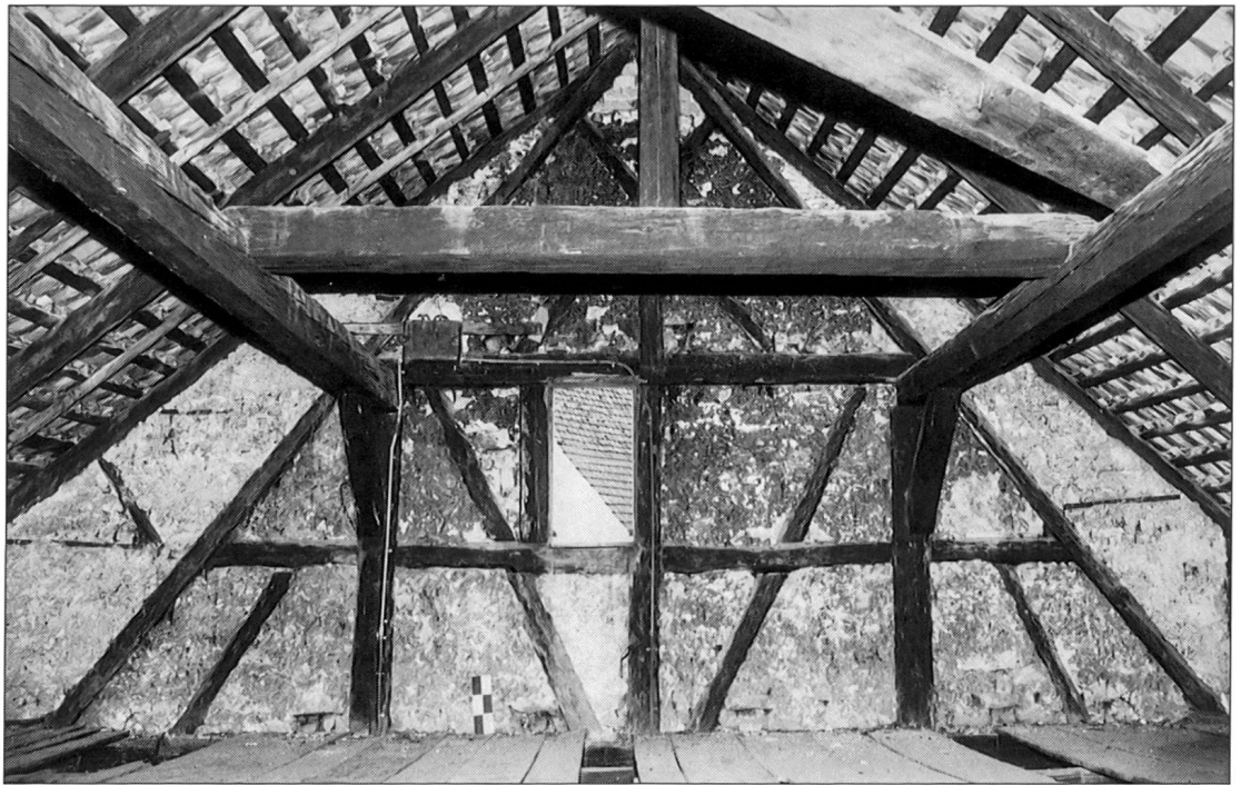
Abb. 16 Magden, Hauptstrasse 111. Fachwerk des Giebeldreiecks und Dachkonstruktion mit stehendem Stuhl von innen. Sparrenlage im Fussbereich nachträglich angehoben. Rauchschwärze durch ursprünglich nur bis zum Dachboden geführte Rauchhurd.
