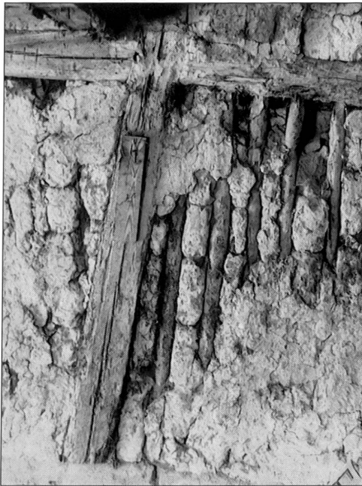
Abb. 21 Möhlin, Bienenweg 91. Fachwerkfüllung aus runden, stehenden Knebeln aus der Bauzeit von etwa 1685 (Trennwand Stall/Remise).
