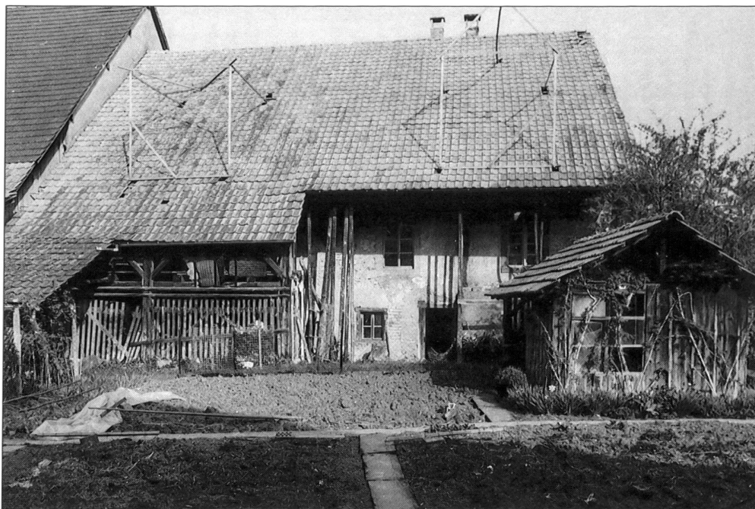
Abb. 2 Kaisten, Dorfstr. 50. Blick von Westen an die hintere Traufseite mit Schopfanbau am Wirtschaftsteil und vorgelagertem Gartenschopf.
