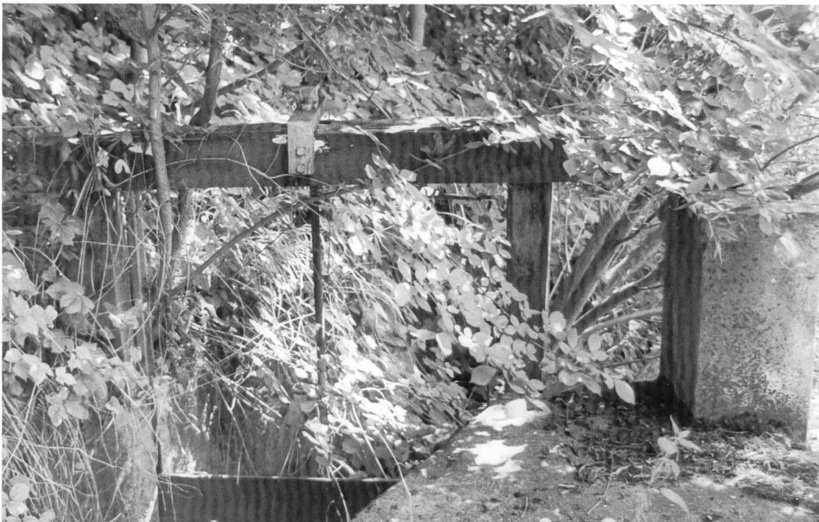
Abb. 3 Einlass zum Wasserkanal der Bandfabrik am Staffeleggbach (Aufnahme von 1991).
