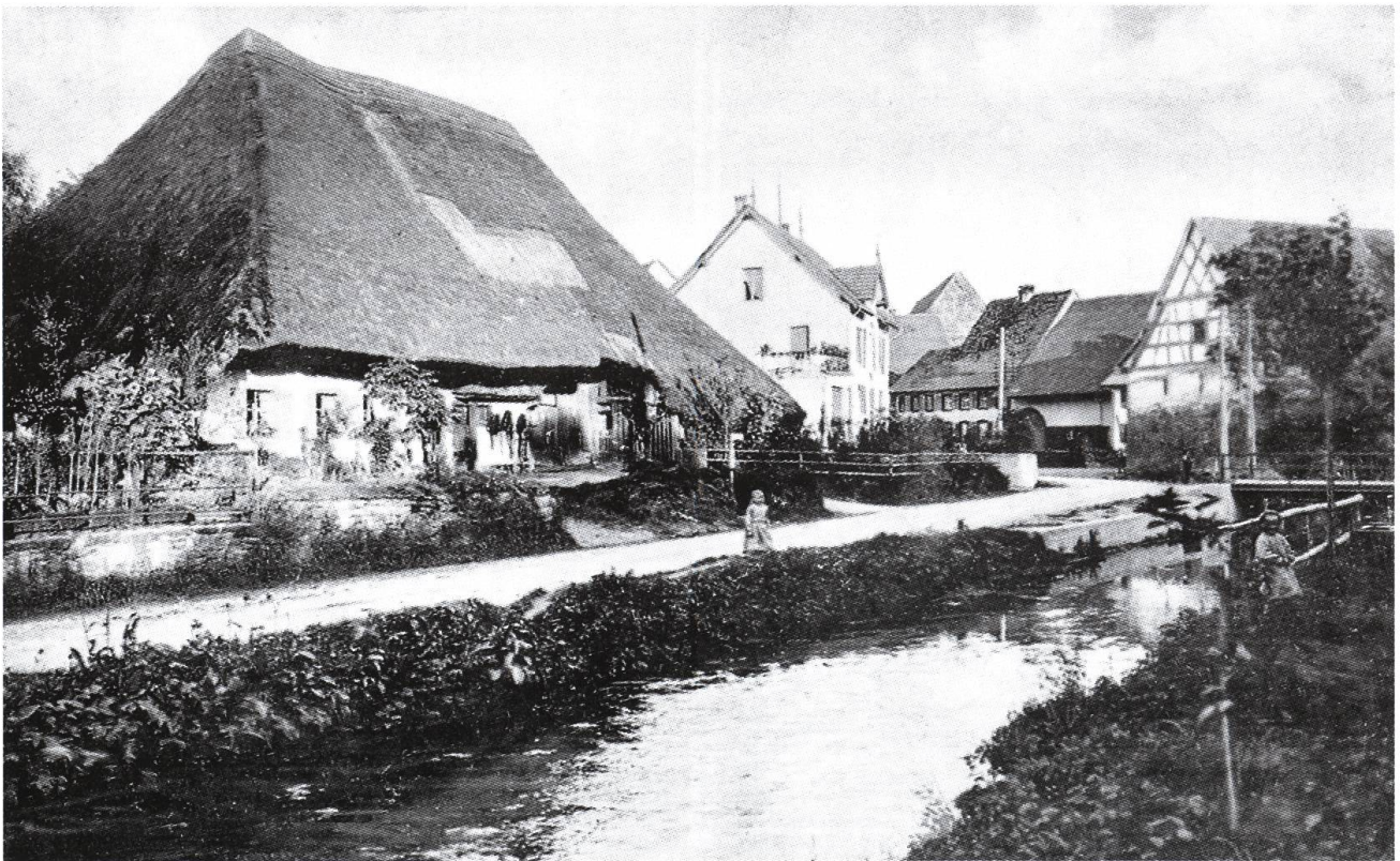
Abb. 5: Möhlin. Dorfpartie um 1900. Links ein strohgedecktes Firstständerhaus mit weit herabreichendem Walmdach. Am links liegenden Wohnteil wurden die ursprünglichen Holzwände durch eine steinerne Mantelmauer ersetzt. In der Bildmitte ein Neubau aus der Zeit um 1900, rechts ein Fachwerkbau des 17. Jahrhunderts.
