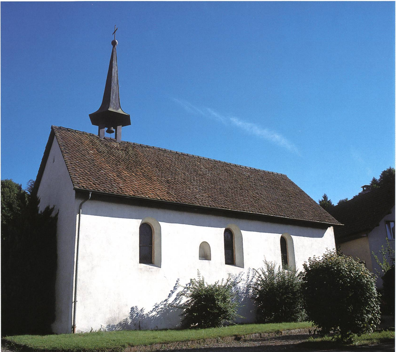
Abb. 7: Rheinsulz CH, Kapelle St. Margaretha. Der Kleinbau, der teilweise ins 11. Jahrhundert zurückreicht, zeigt eine für zahlreiche Kirchen und Kapellen des Früh- und Hochmittelalters charakteristische Grundform. An den kleinen, rechteckigen Versammlungsraum schliesst übergangslos der Chorbereich an. Beide Raumelemente liegen unter einem durchgehenden, von einem Dachreiter bekrönten Satteldach. (Bild: Erich Treier, Oberhof CH)
