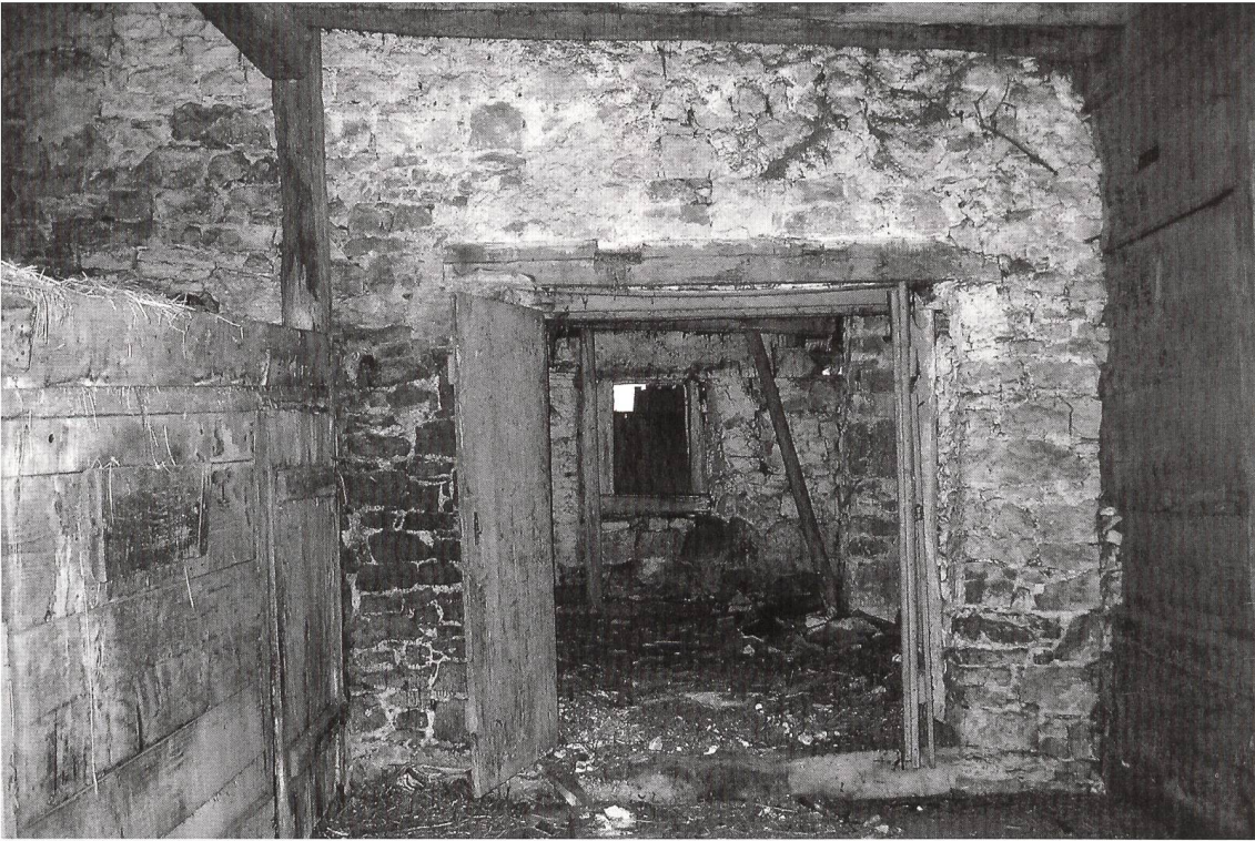
Abb. 11 Doppelhaus Frick, Kirchmattweg Nr. 5. Blick von der Tenne in den südlichen Anbau (ehemalige Wagnerei), links ein Futterloch der ganz aus Holz gezim- merten Trennwand Tenne/Stall.
