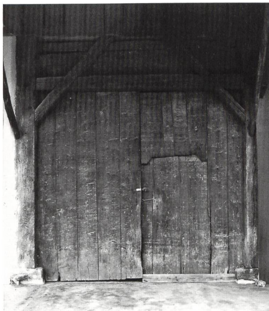
Abb. 14 Doppelhaus Frick, Kirchmattweg Nr. 5. Scheunentorkonstruk- tion mit doppeltem Jochbalken. Doppel- flügelntor, rot-schwarz gefasste Einkerbungen über dem Mannstor. Die eichenen Wand- ständer von 1610 stehen in Schwell- schlössern.
