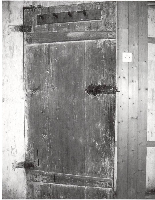
Abb. 18 Doppelhaus Frick, Kirchmattweg Nr. 5, ursprüngliche Küchentüre, mit modernem Schloss versehen, der Russ mit heller Farbe über- strichen.
