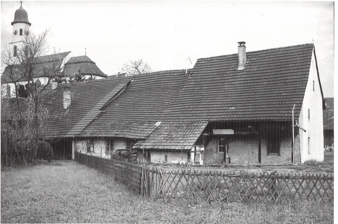
Abb. 10 Doppelhaus Frick, Kirchmattweg Nr. 5/Nr. 7, Ansicht der südlichen Hinterhof- seite mit Anbauten des 19./20. Jahrhunderts (Wagnerei, Schweine- stall, Abort) bei Nr. 5.
