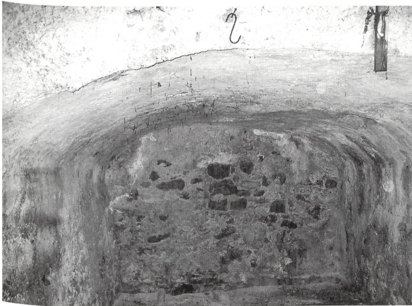
Abb. 17 Doppelhaus Frick, Kirchmattweg Nr. 5. Sorgfältig verputztes Kellergewölbe von 1610.
