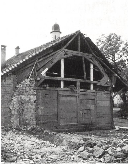
Abb. 24 Doppelhaus Frick, Kirchmattweg Nr. 7, nach Abbruch von Nr. 5: Wandständer- konstruktion im Tenn.
