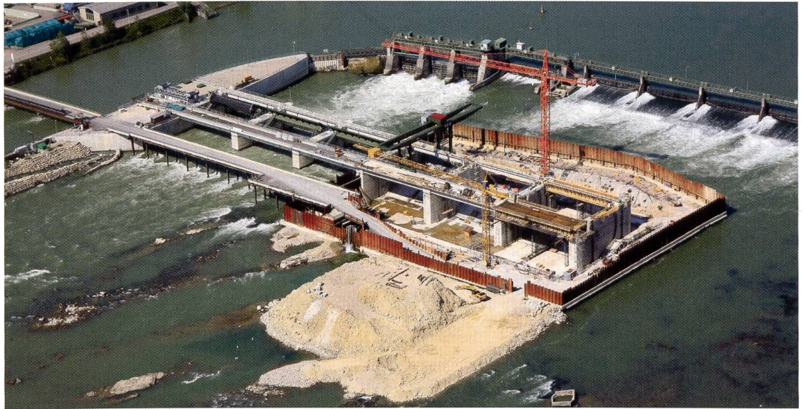
Neubau des neuen Wehrs in Rheinfelden, oben ist noch das alte zu sehen, 27. Juni 2006. (Frdl. Genehmigung der Fa. Meyer, Hasel)
