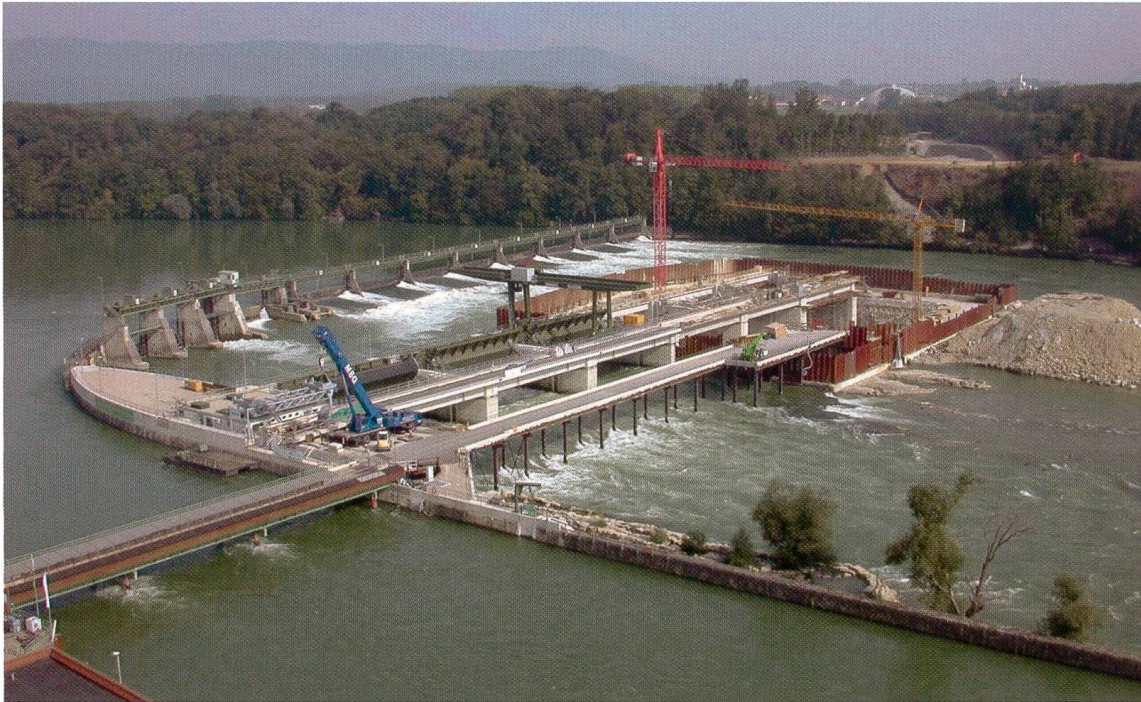
Baufortschritt am neuen Wehr, 27. September 2006. (Frdl. Genehmigung der Fa. Meyer, Hasel)
