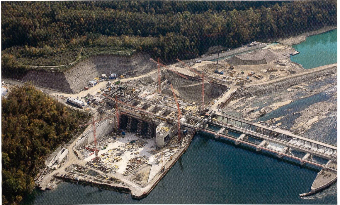
Bau des Maschinenhauses, 19. Oktober 2009. (Frdl. Genehmigung der Fa. Meyer, Hasel)
