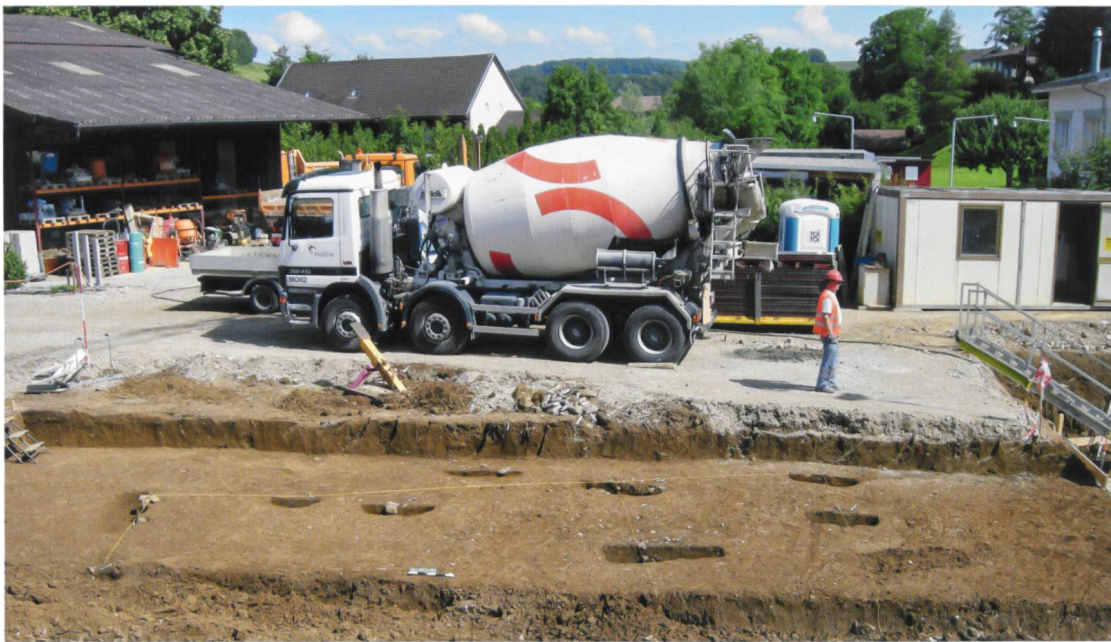
Herznach, Unterdorf: Der laufende Beton- mischer vor einem freigelegten Teil des frühmittelalterlichen Pfostenbaus. Foto Kantons- archäologie Aargau, David Wälchli.
