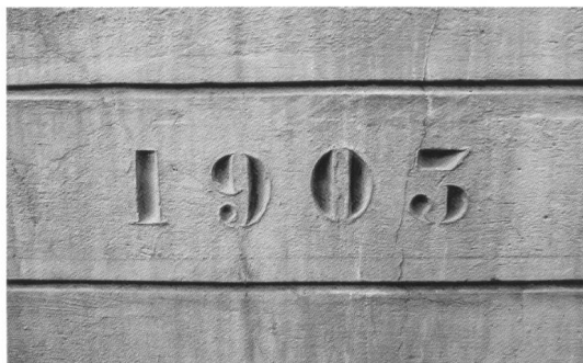
Die Jahrzahl 1903 am Treppenaufgang belegt Umbauarbeiten, die Friedensrichter Karl Ruede ausführen liess.
