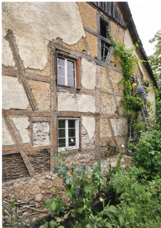
Abb. 5 Die Südwestfassade. Unter dem Verputz kam das Riegelwerk mit den verschiedenen Arten von Aus- fachungsmaterialien zum Vorschein.
