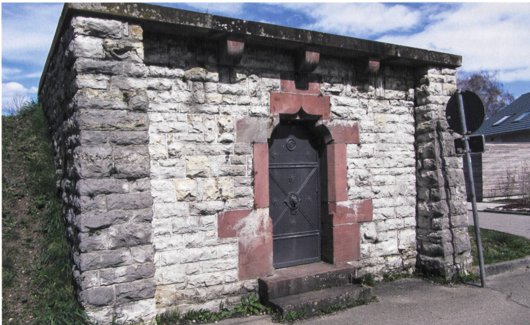
Wasserreservoir in Karsau aus dem Jahr 1907.
