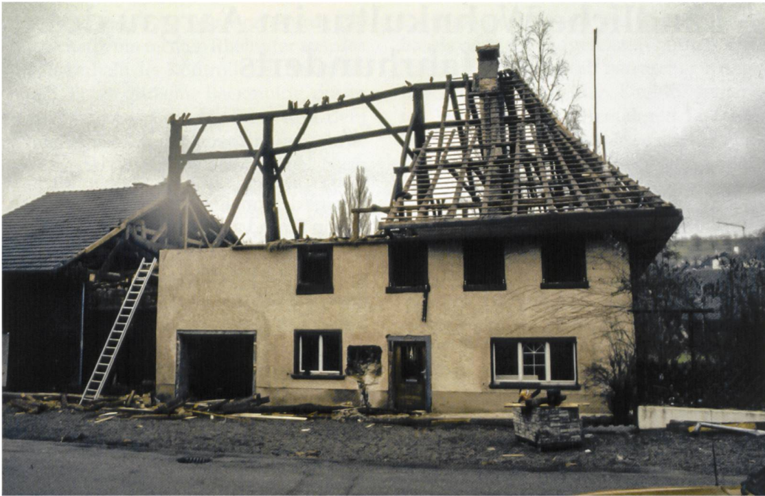
Abb.2 Die freigelegte Hochstudkonstruktion des Hauses Bodengasse 54 in Wölflinswil beim Abbruch im Winter 1994/95. (D. Wälchli)
