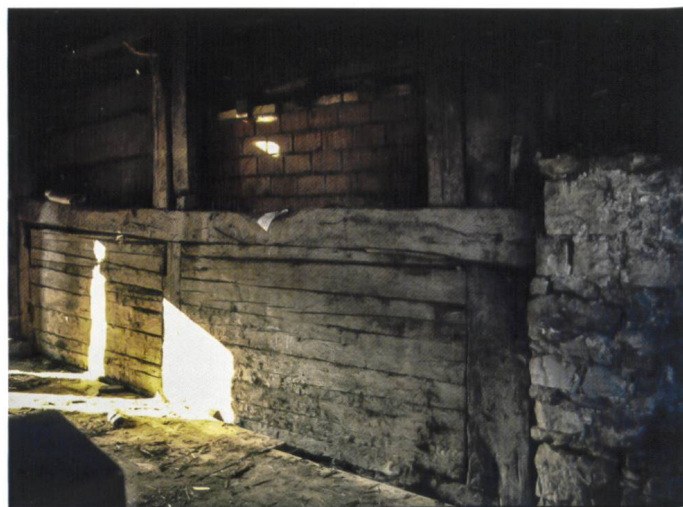
Abb. 6 Ankerbalken im Haus Bodengasse 54 in Wölflinswil. (D. Wälchli)
