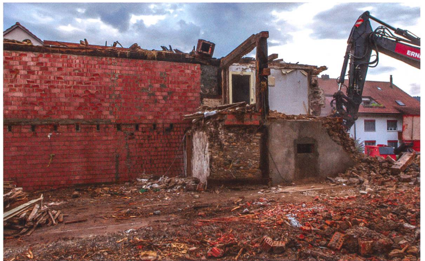
Abb. 4 Abbruchsituation, Südansicht. Backsteinerne Wand zwischen Wohn- und Ökonomietrakt sowie die letzten, rauchschwarzen Bauhölzer des Hochstudbaus (vgl. Abb. 2).
