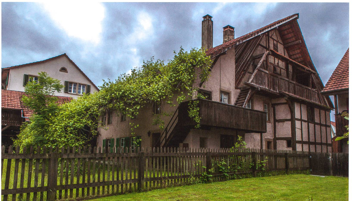
Abb. 6 Nordostfassade, Ostansicht. Geriegelte Giebelwand des Wohnhauses mit Laube, 18. Jh.
