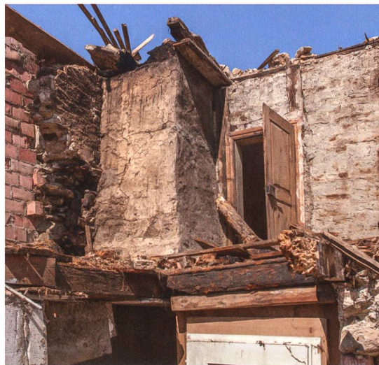
Abb. 7 Abbruchsituation. «Füürbühni» mit gemauertem Kamin aus der Zeit um 1800.
