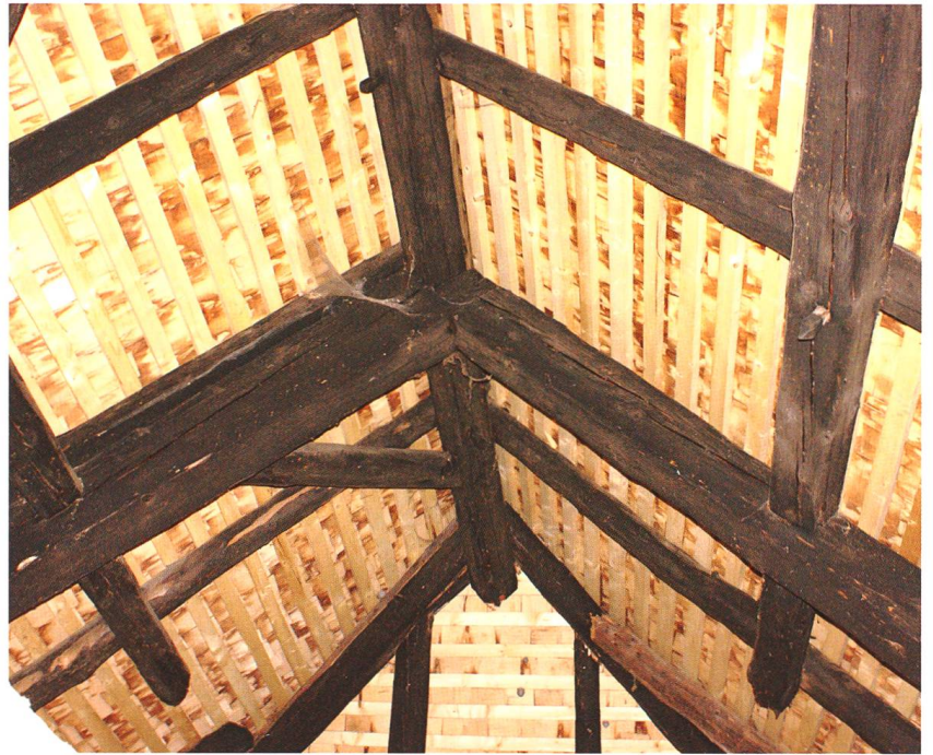
Abb. 8 Blick auf das Traggerüst im 2. Dachgeschoss.
