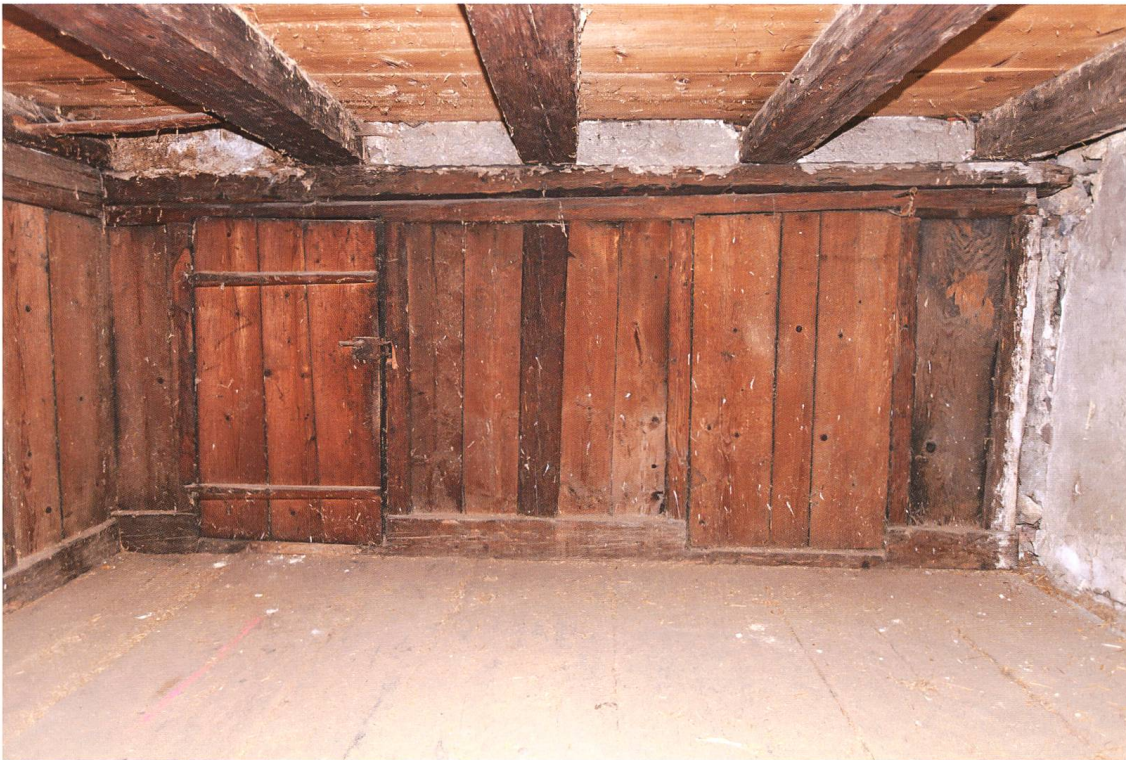
Abb. 8 Längswand in Kammer R 1.3. Rechts ist sie aus dem Mauerwerk ausgeföhren.
