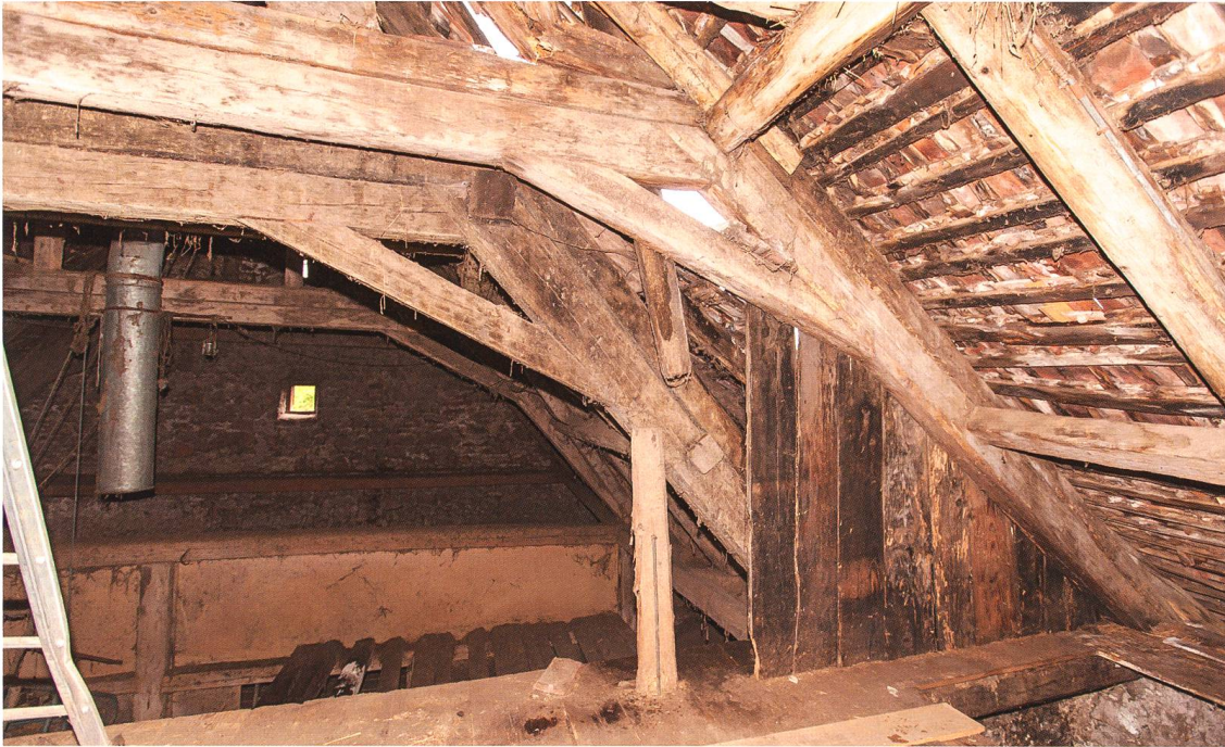
Abb. 6 Liegende und stehende Pfette der Dachstühle von 1777/78 d und 1808 d.
