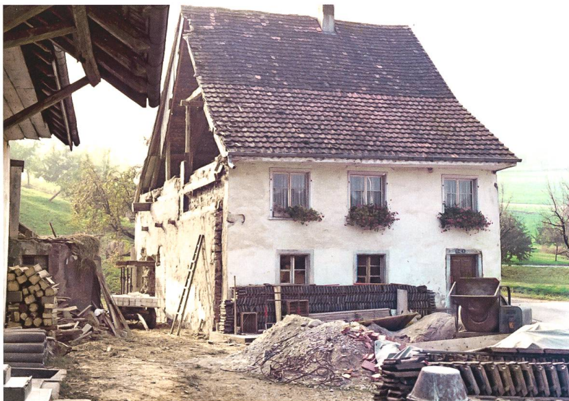
Abb. 12 Wohntrakt des kernbauzeitlichen Hochstudhauses an der Kirchstrasse 5 vor dem Umbau.
