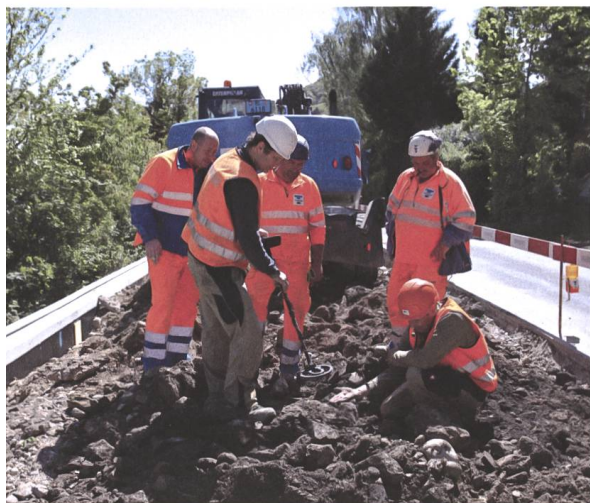
Abb. 10 Staunende Strassenbauer. An der Hauptstrasse in Mumpf finden Mitarbeiter der Kantonsarchäologie, Daniel Huber und Rolf Jeltsch, in einer spät- antiken Brandschicht zahlreiche spätantike Münzen.
