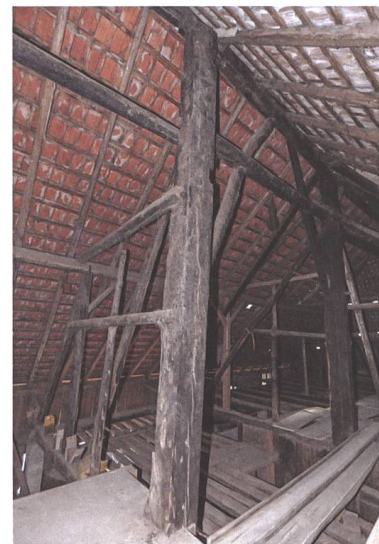
Abb. 5 Hochstudkonstruktion von 1551/52 an der Unterdorfstrasse 19 in Wallbach.
