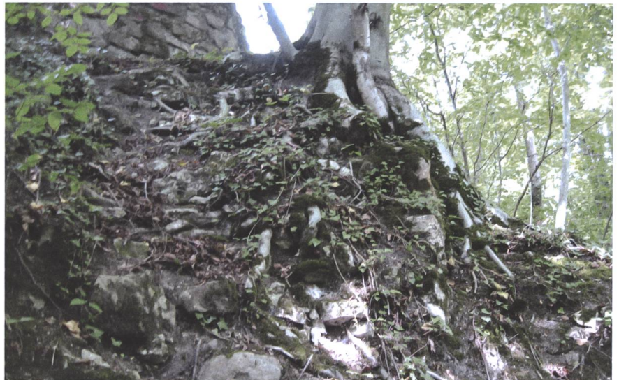
Abb. 18 Wehr. Im Hang stecken noch geringe Reste des südöstlichen Rundturms (oben die modern im Bogen abgemauerte Ringmauerecke; 2017).
