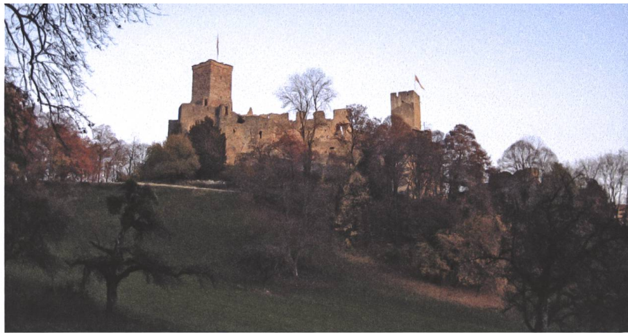
Abb. 15 Rötteln. Die Oberburg, Westseite. Anstelle des Bergfrieds (links) ist für die Frühzeit mit einem Wohnturm zu rechnen. Der kleinere Turm «Giller» rechts enthält im unteren Bereich offenbar noch Mauerwerk des 12. Jhs. (2011).
