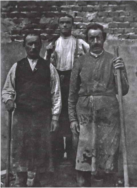
Abb. 8 Arbeiter in der Flotschi (Tuchwasch- anlage) um 1905.
