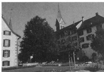
Arbeitsbüro Pro-G im Schulhaus Kantonale Sprachheilschule Münchenbuchsee
