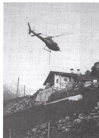
Betonieren der Stützmauer per Helikopter
