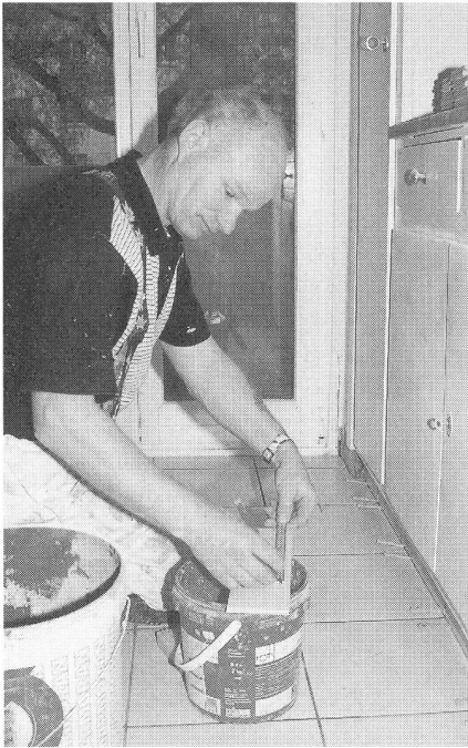
◀ Plattenarbeiten in Küchen für einen Wohnblock mit 12 Wohnungen in Luzern
