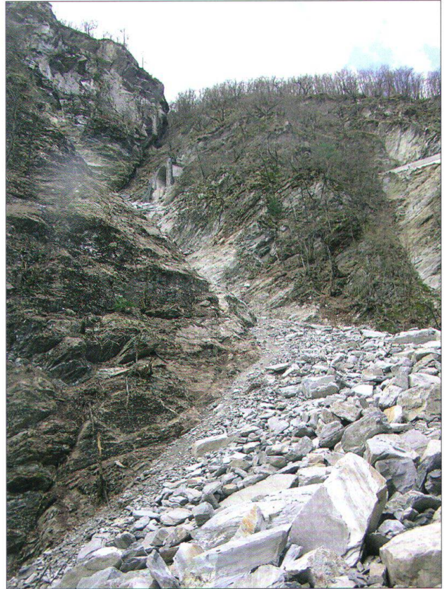
Fig. 11: Blick von der Calancasca hinauf über den Schuttkegel ins Tal der Hölle, wo seit dem 3. Februar 2006 die Brücke fehlt.
