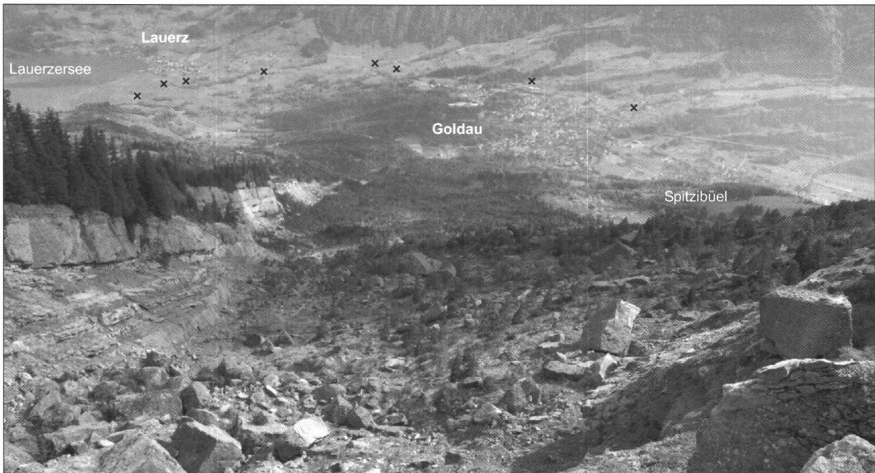
Fig. 5: Übersicht über den Prozessraum des Bergsturzes von 1806. Im Vordergrund ist die mit Blockschutt bedeckte Gleitfläche, links der östliche Abrissrand mit Mergeln und Feinsandsteinen (unten) sowie massiger Nagelfluh (oben) erkennbar. Die Kreuze markieren die ungefähre Lage der entferntesten, heute sichtbaren Sturzblöcke (Foto: Ernst Immoos).
