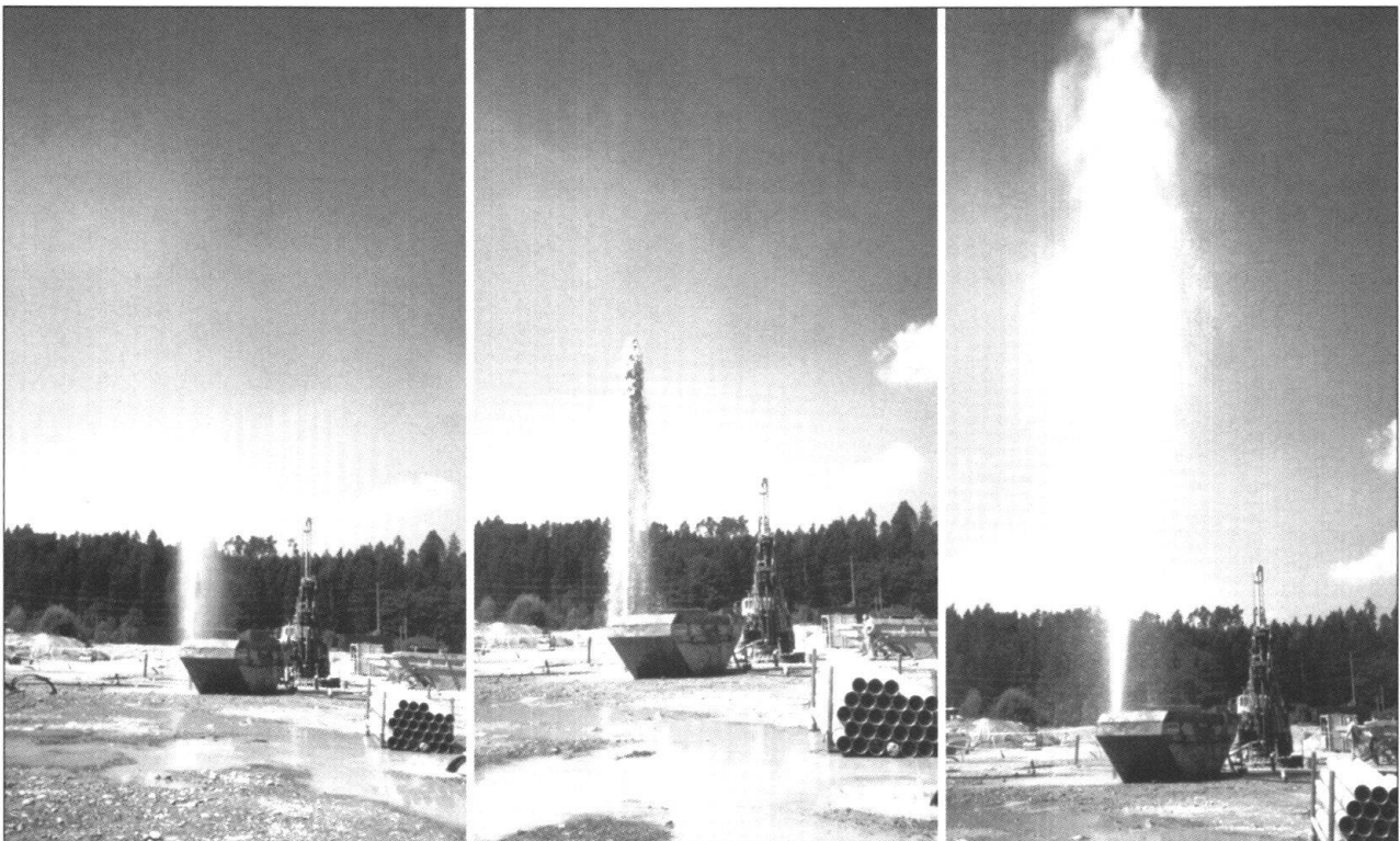
Fig.14: Rund 30 m hoher «Blow Out» aus der Pilotbohrung beim Spülen des 12 m entfernten Sondenlochs Nr. 26.
