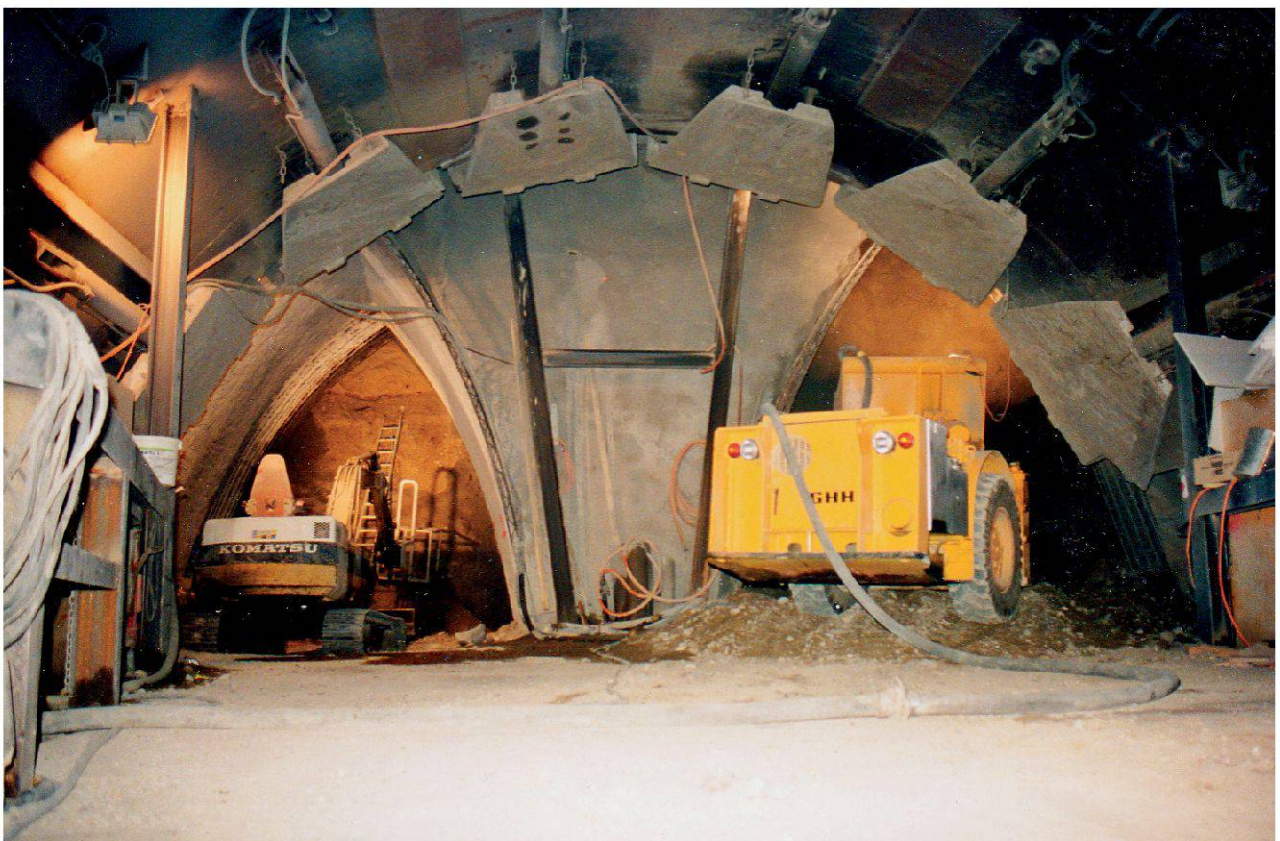
Fig. 4: Fäsenstaubtunnel, Vortrieb Nord, km 16.814: Umstellung Schildvortriebsverfahren [zurückgezogene Brustsicherungsklappen am oberen Bildrand] auf Teilausbruchverfahren [3-teiliger Kalottenvortrieb] mit Spritzbetonsicherung (Foto S. Frank, September 1991).
