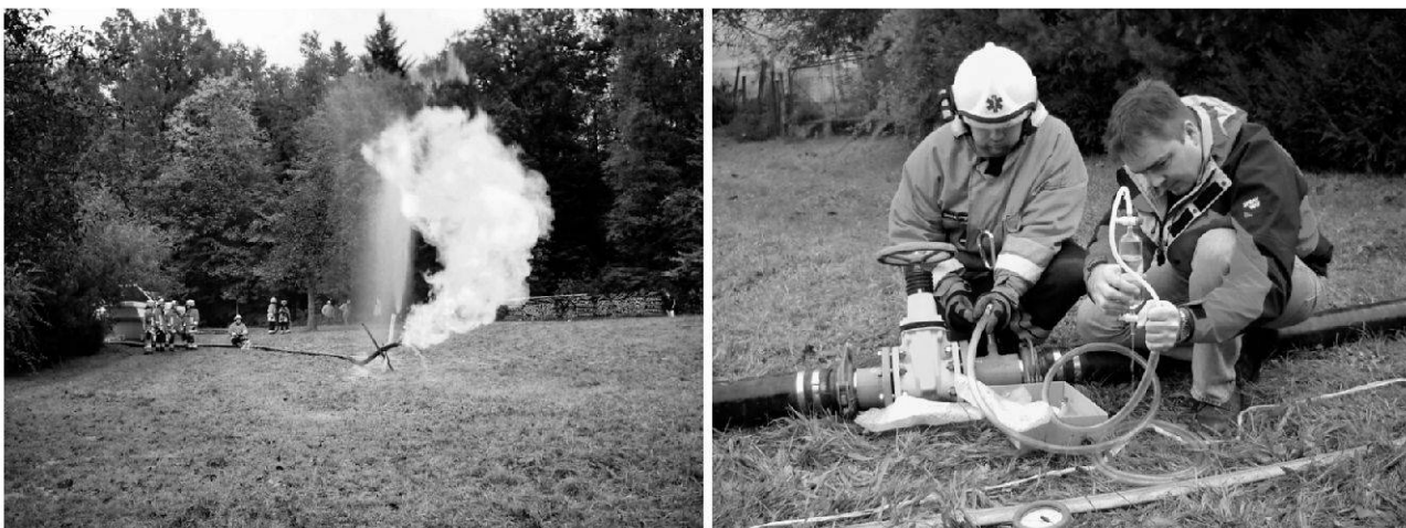
Fig. 4: Links: Erdgasaustritt nach der kontrollierten Entzündung durch die Feuerwehr. Rechts: Gasbeprobung am Absperrschieber der Spülungsleitung. Für eine folgende Druckmessung wurde nach Abschluss der Probenahmen ein Manometer (im Vordergrund des Bildes) an die Abzweigung geschraubt.
