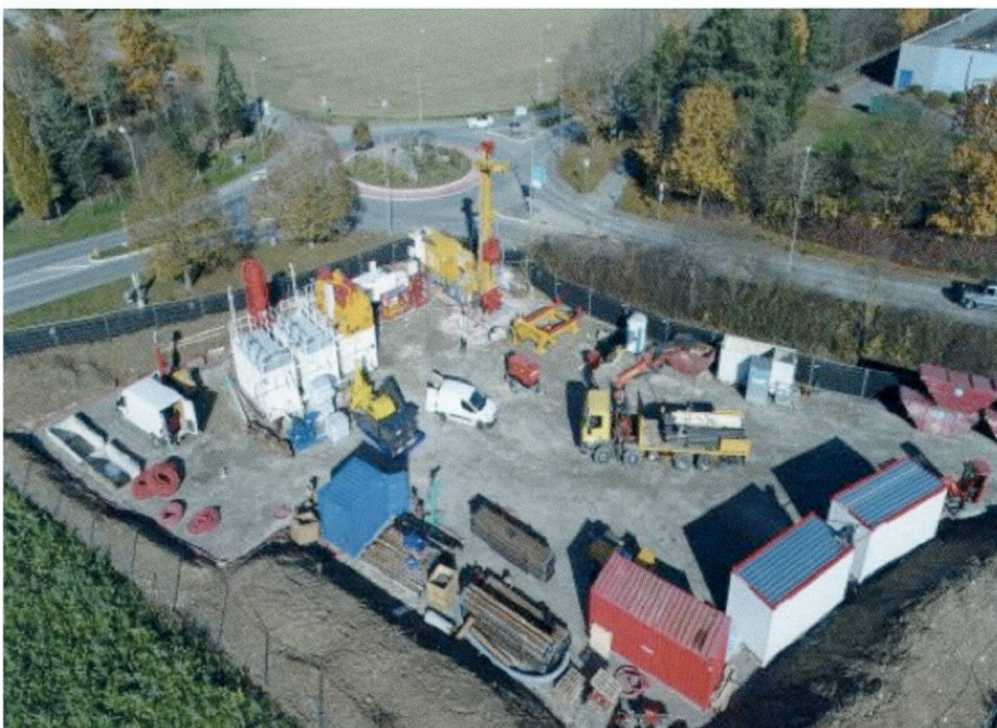
Fig. 1: Bohrplatz mit Bohrgerät und den zugehörigen Installationen und Behausungen (Bild: geothermie.ch).
