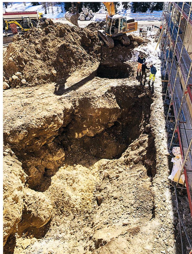
Fig. 13: Das zuletzt vorgefundene Höhlensystem in der vierten Etappe. Rechts im Bild ein bereits fertiggestellter Teil der neuen ARA (Bild M. Berweger, 22.03.2019).
