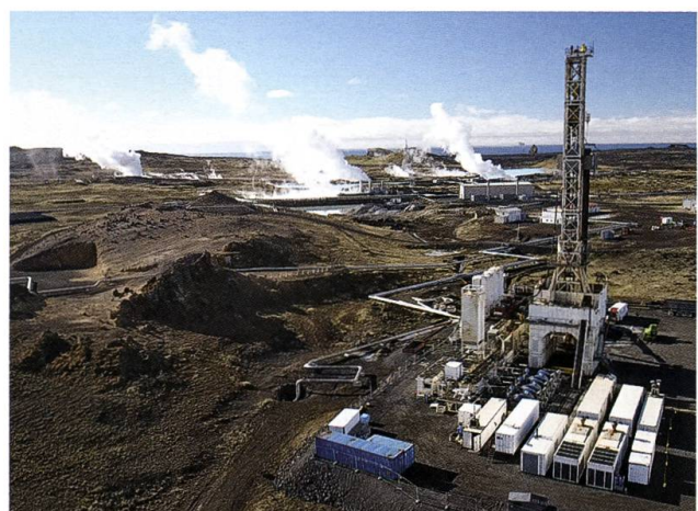
Fig. 6: Bohrung IDDP-2 (rechts) im Reykjanes Geothermalfeld, Herbst 2016. Im Hintergrund der Atlantik, aus dem sich das Geothermalsystem entlang von Grabenbrüchen mit Meerwasser speist.
