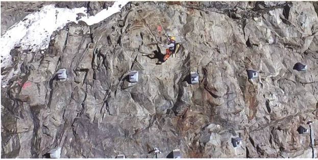
Fig. 13: Überprüfung der Ankerköpfe durch den Geologen.
