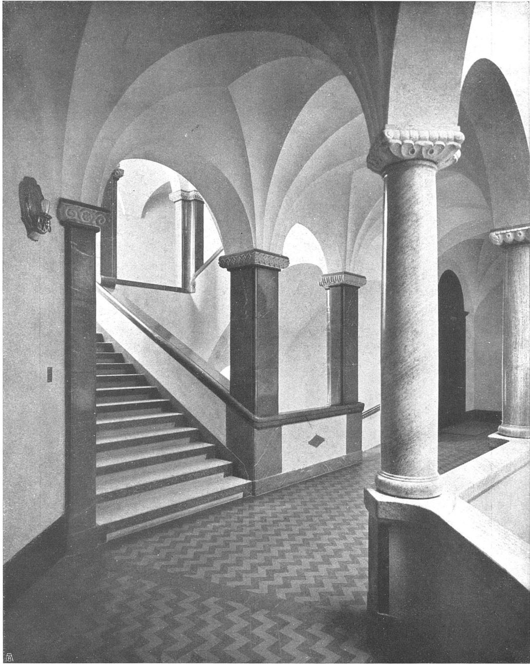
Beleuchtungskörper in der Halle des Peterhofes in Zürich
