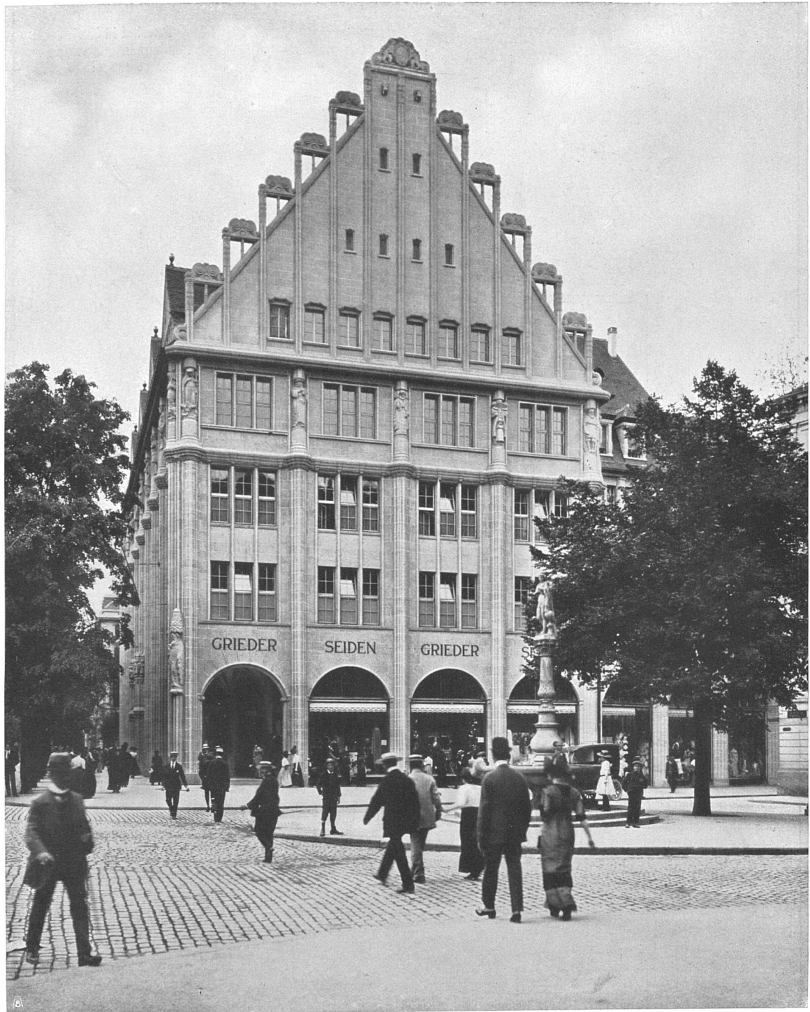
Peterhof in Zürich Giebelfassade Paradeplatz
