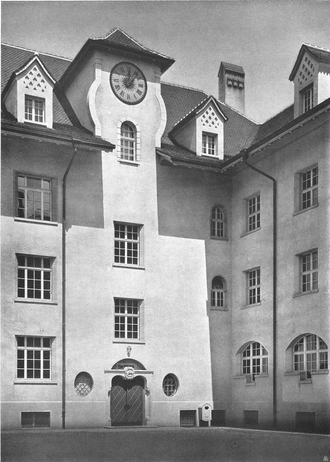
Breitfeldschulhaus Bern Partie der Hoffassaden
