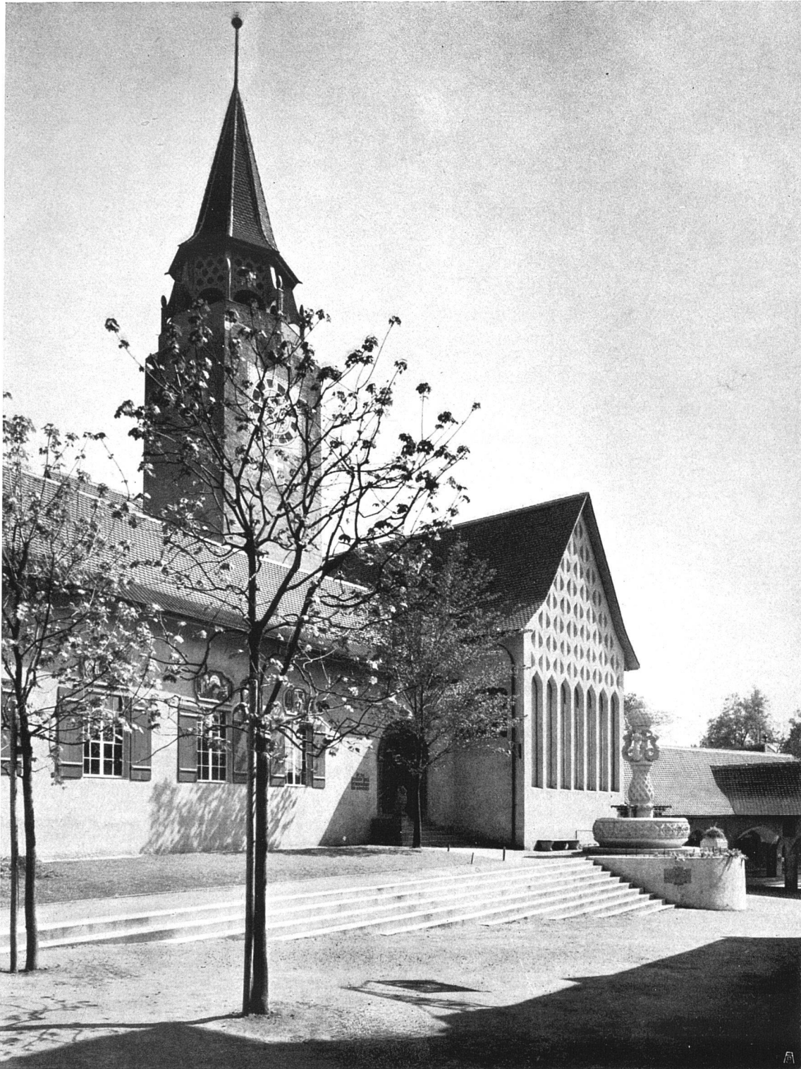
Platz vor Kirche mit Brunnen. Hofbrunnen in Kunststein, nach Modell von W. Schwerzmann ausgeführt von „Schweiz. Baubedarf A.-G.“ (vorm. P. Kramer), Herzogenbuchsee
