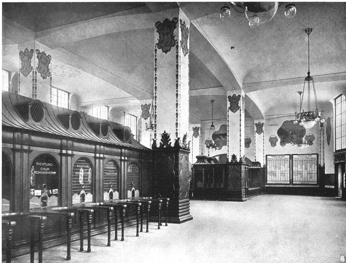
Bahnhof St. Gallen, Schalterhalle
