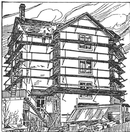
Ganz eingerüstetes Haus
