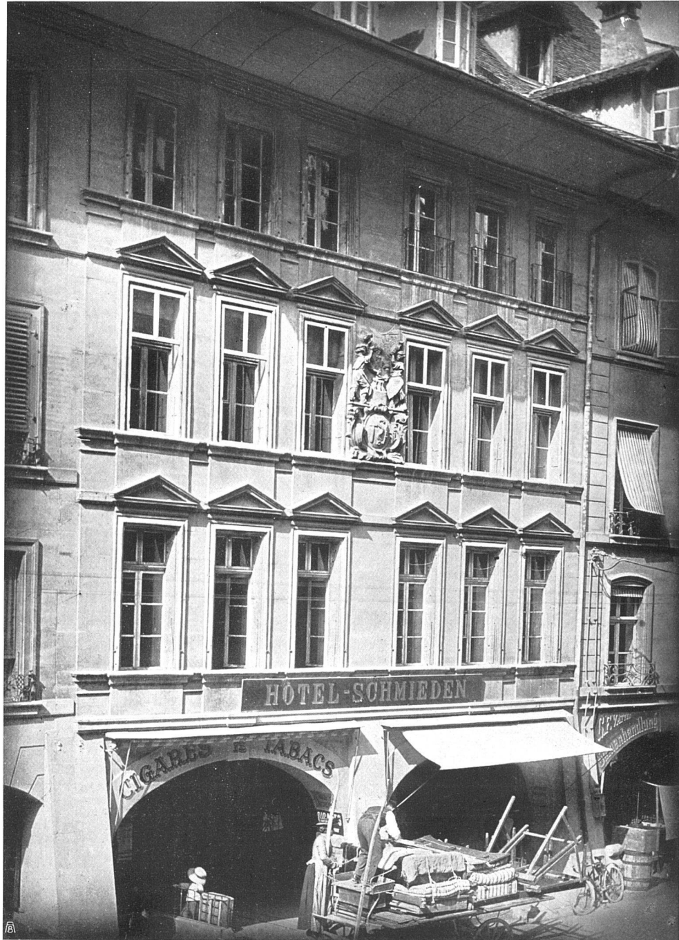
Das alte Zunftthaus zu Schmieden an der Marktgasse in Bern. Vor dem Abbruch
