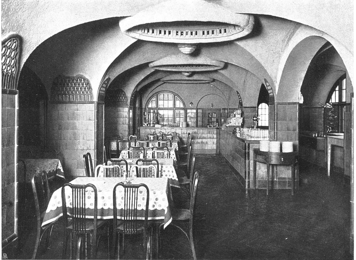
Volkshaus Bern. Großes Restaurant. Rabitzgewölbe und Stuckrosetten: Gips- und Malergenossenschaft Bern
