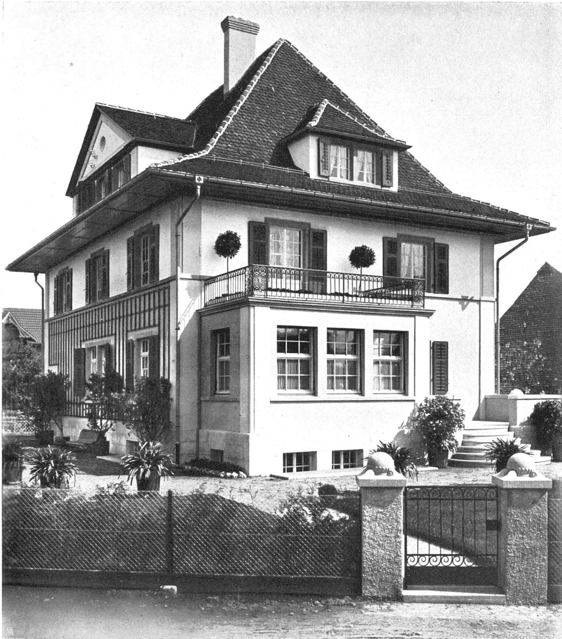
Wohnhaus des Herrn Fr. Baumberger, Brauereibesitzer, an der Bahnhofstraße in Langenthal. Ansicht von Süd-Westen. Arch. B. S. A. Hector Egger, Langenthal
