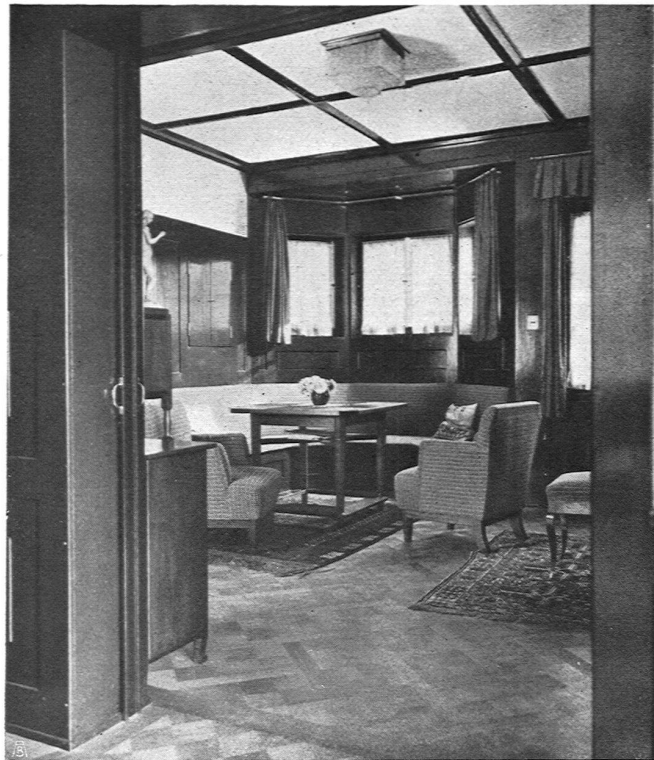
Wohnraum mit Eternit-Deckenfüllungen
