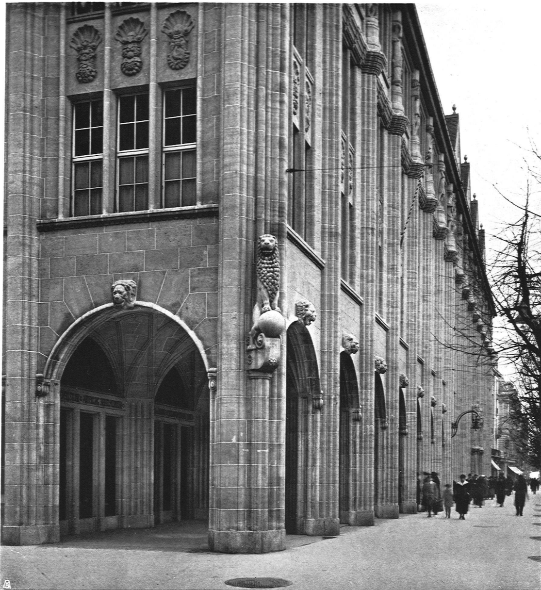
Leuenhof und Peterhof in Zürich. Gesamtfassade nach der Bahnhofstrasse, Bildhauerarbeiten nach Entwürfen von Schwerzmann und Münch ausgeführt von Th. Bertschinger Söhne, Zürich-Lenzburg
