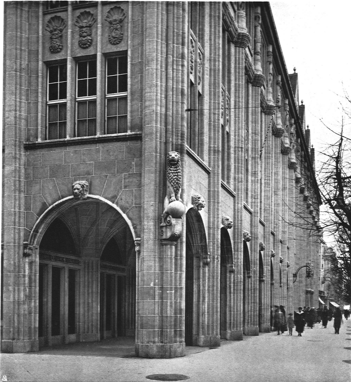
Leuenhof und Peterhof in Zürich. Gesamtfassade nach der Bahnhofstrasse, Bildhauerarbeiten nach Entwürfen von Schwerzmann und Münch ausgeführt von Th. Bertschinger Söhne, Zürich-Lenzburg
