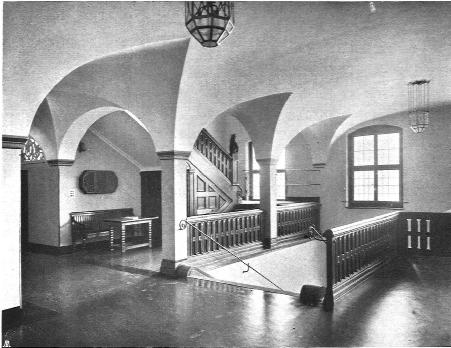
Halle im 1. Stock mit Treppenaufgang zum 2. Stock. Treppen und Treppengeländer in Nußbaumholz, ausgeführt von Hektor Schlatter & Co., Schreinerei S.W.B., St. Gallen
