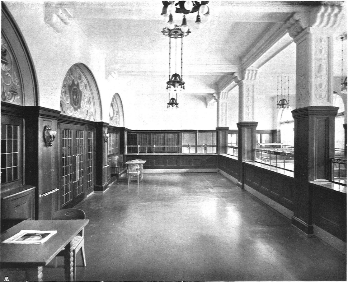
Schalterhalle der Kantonalbank in Herisau. Schreinerarbeiten vom Schreinermeisterverband Herisau Beleuchtungskörper: Baumann, Koelliker & Co., Zürich. Dekorative Malerei: Maler Hartung in Zürich
