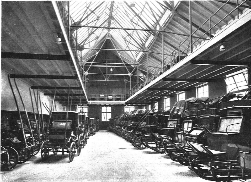
Das Postgebäude in Aarau. Blick in die Postremise. Eisenkonstruktion für Dachstuhl: Alfr. Kuhn, Aarau; Projekt: Thurnharr und Bolliger, Ingenieure, Zürich. Zimmerarbeiten: Baugeschäft M. Zschokke A.-G., Aarau
