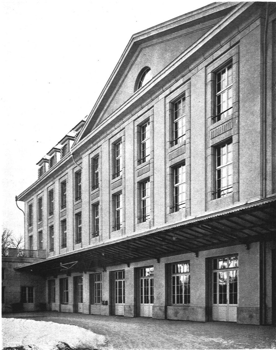
Das Postgebäude in Aarau. Rückfassade. Markise: Oehler & Co., Aarau, und Martin Keller, Zürich. Glasarbeiten: Baugeschäft M. Zschokke, A.-G., in Aarau
