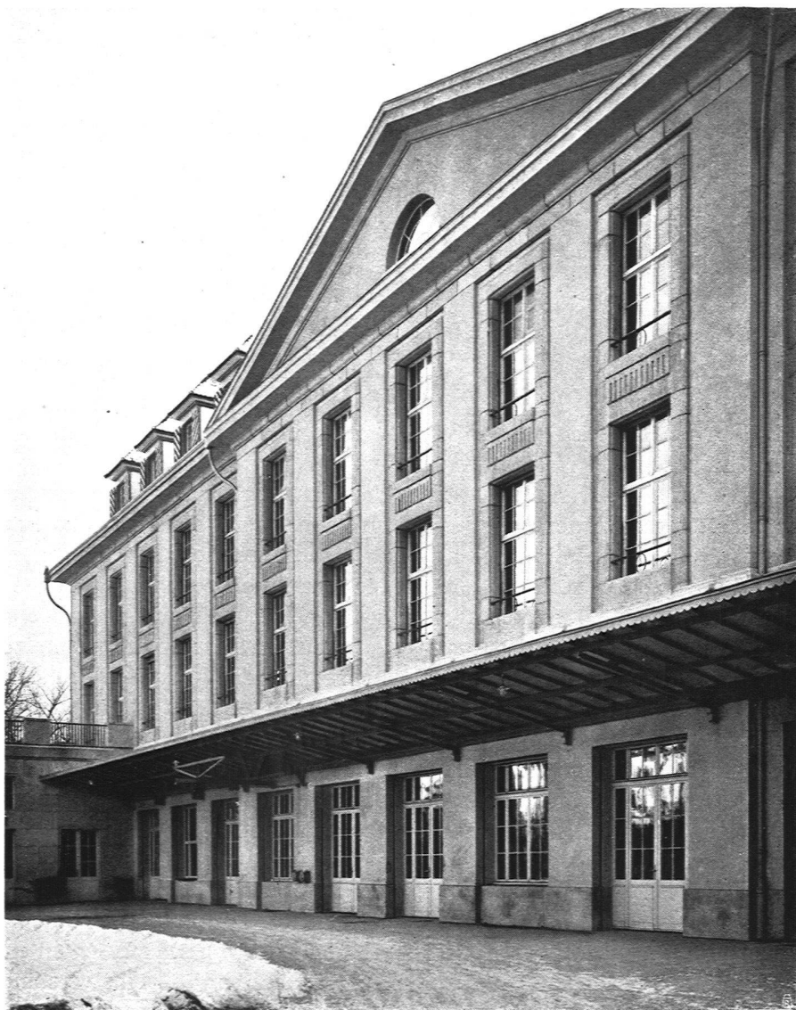
Das Postgebäude in Aarau. Rückfassade. Markise: Oehler & Co., Aarau, und Martin Keller, Zürich. Glasarbeiten: Baugeschäft M. Zschokke, A.-G., in Aarau
