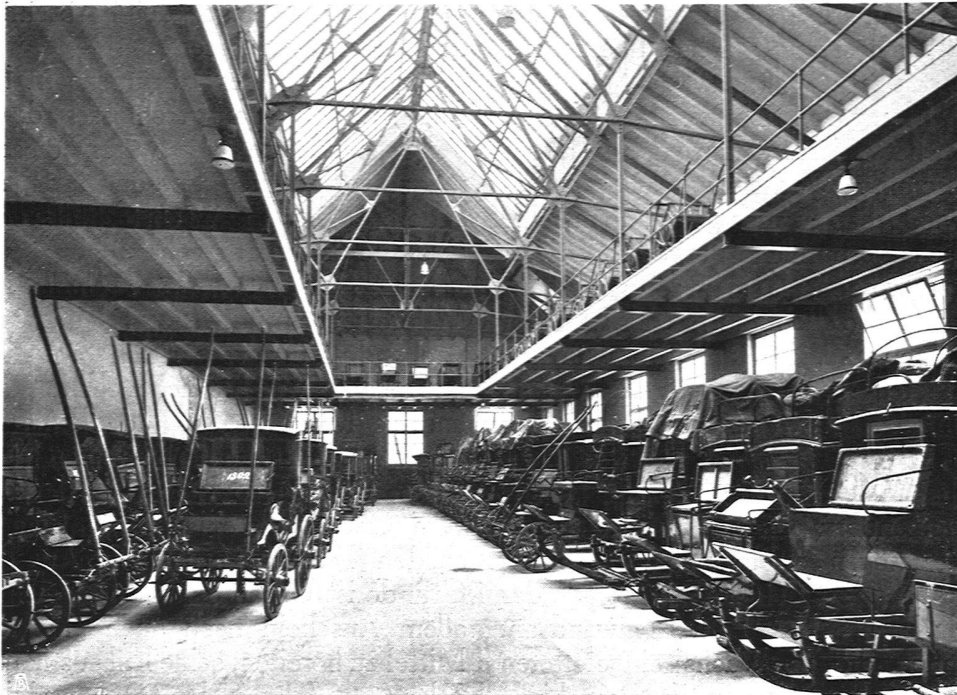
Das Postgebäude in Aarau. Blick in die Postremise. Eisenkonstruktion für Dachstuhl: Alfr. Kuhn, Aarau; Projekt: Thurnharr und Bolliger, Ingenieure, Zürich. Zimmerarbeiten: Baugeschäft M. Zschokke A.-G., Aarau
