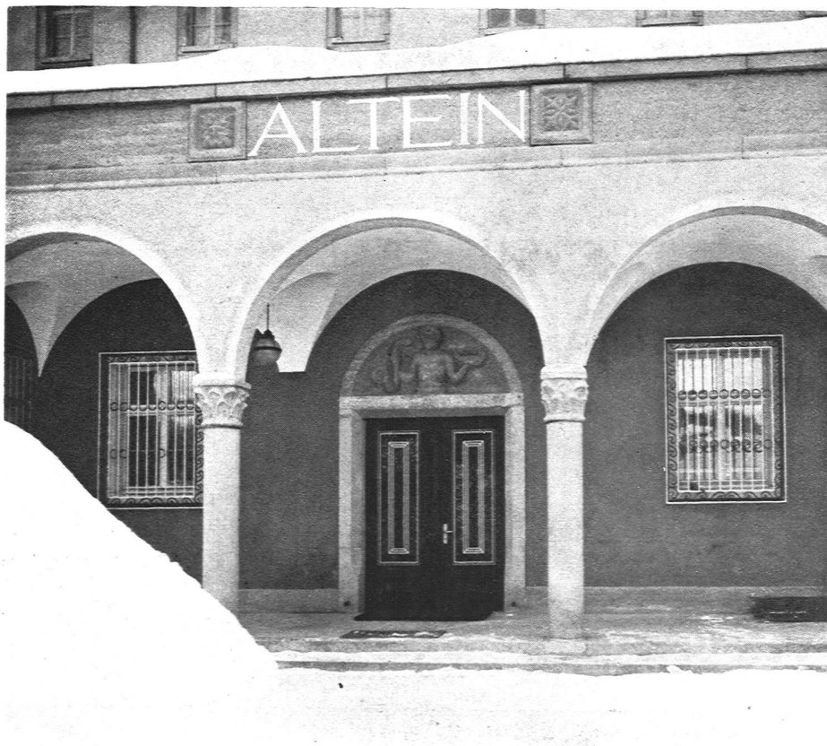
Arch. B. S. A. Schäfer & Risch, Chur. Sanatorium Altein, Arosa. Nordseite (Umgebungsarbeiten unvollendet) Unten: Haupteingang, Fenster und Türgitter von F. Jenny, Kunstschlosserei, Davos-Platz
