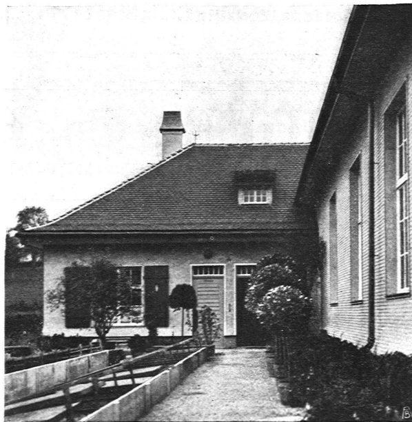
Pflanzenhaus mit äusserer Eternit-Wand- verschindelung
