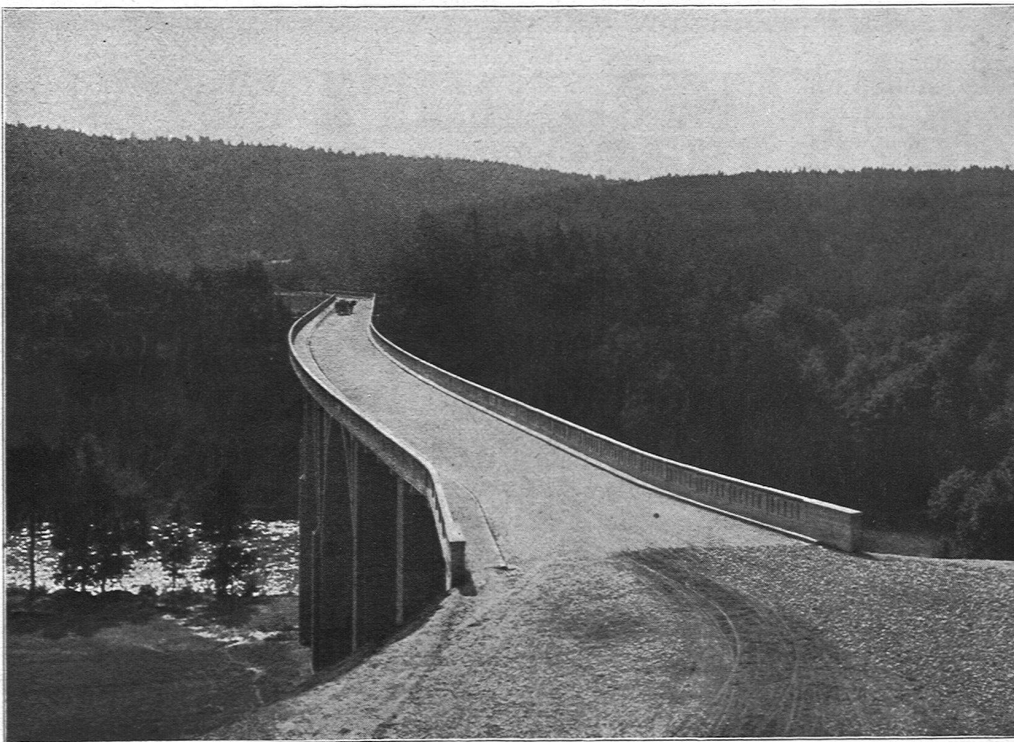
Halenbrücke bei Bern
