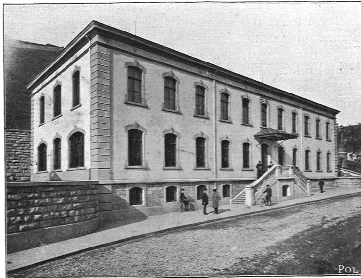
Verwaltungs- gebäude der A.-G. der Eisen- und Stahlwerke vor- mals G. Fischer, Schaffhausen.
