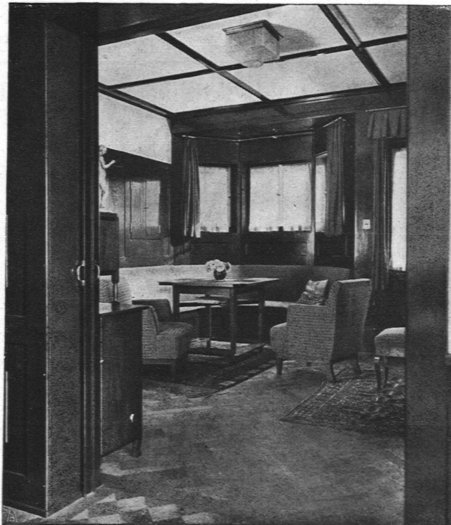
Wohnraum mit Eternit-Decken- füllungen
