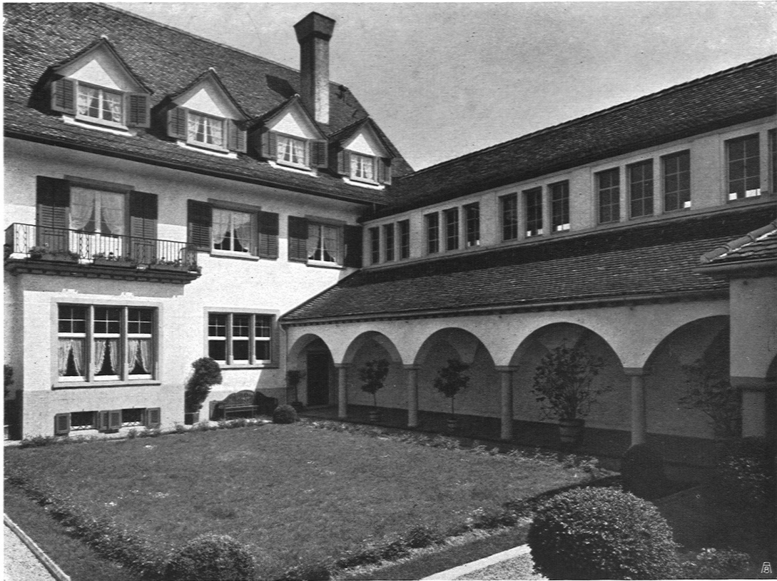
Haus Richard Kisling am Zürichberg mit Galerieanbau und Wandelgang
